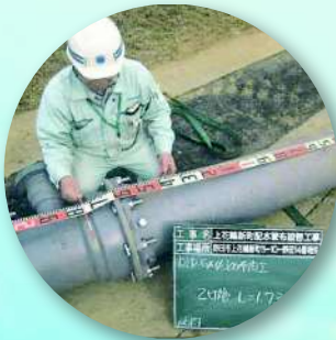
耐震管による配水管の整備
