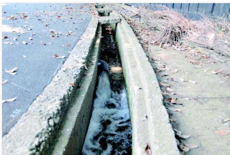
ドレン作業のようす
