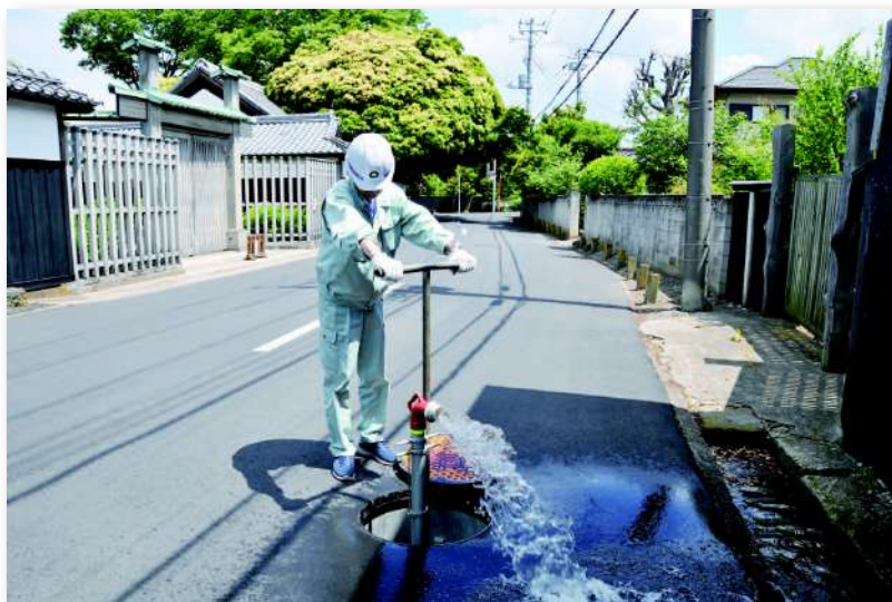
洗管作業のようす
