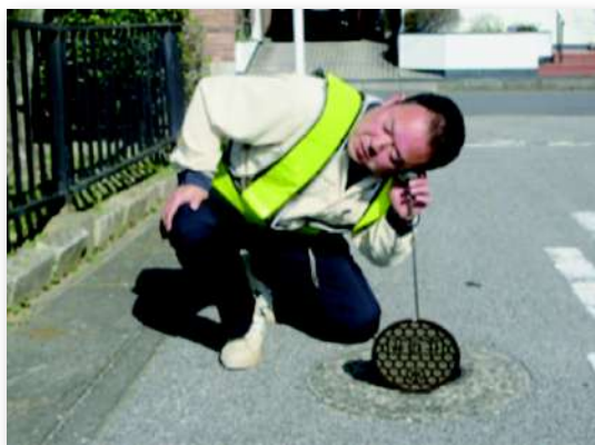
聴音による漏水調査のようす
