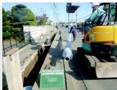
老朽管布設替のようす
