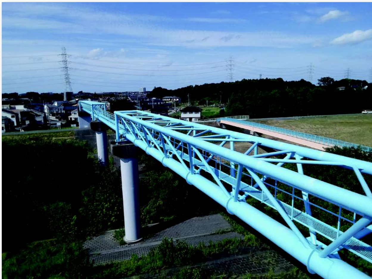
北千葉送水管(利根運河水管橋)
