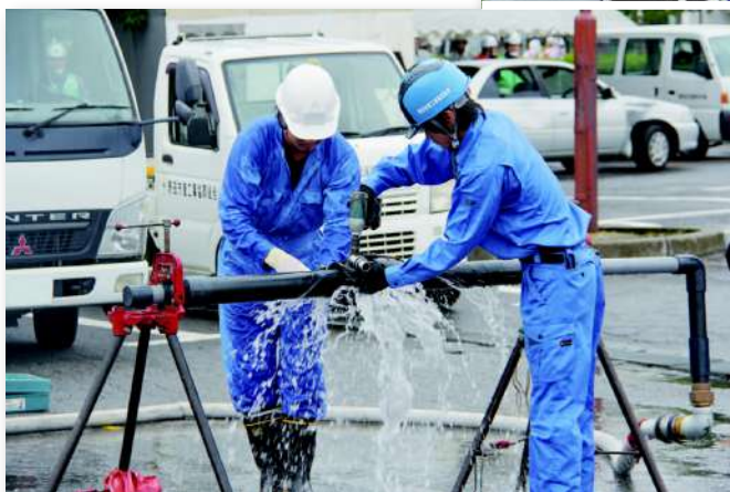
漏水復旧訓練のようす
