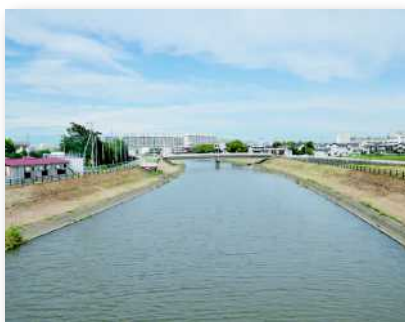
北千葉導水路
