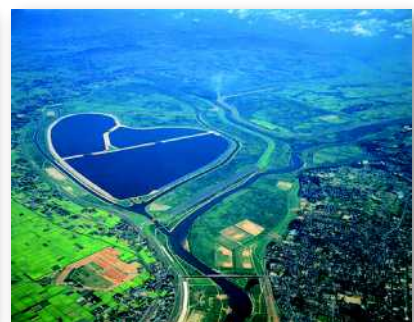
渡良瀬貯水池
