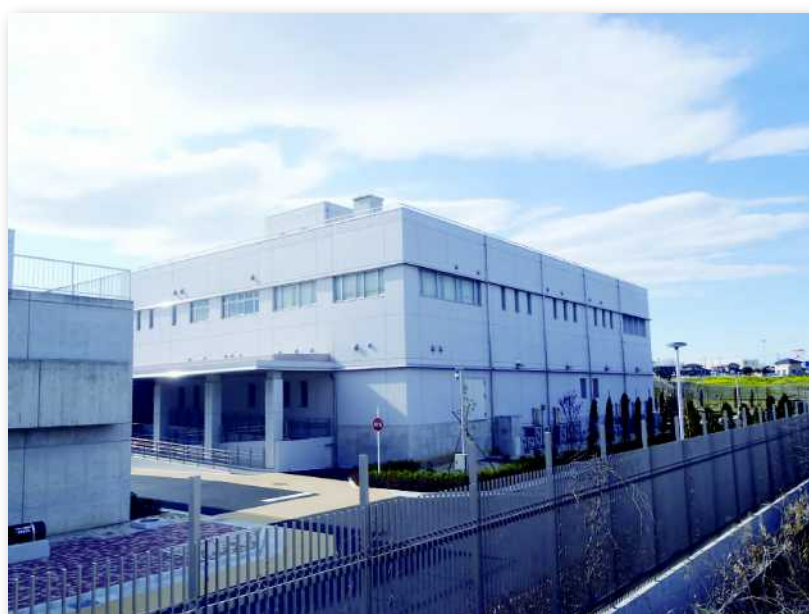
北千葉広域水道企業団 オゾン処理施設
