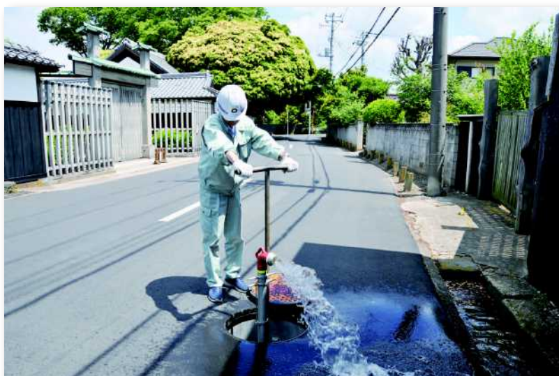
洗管作業のようす
