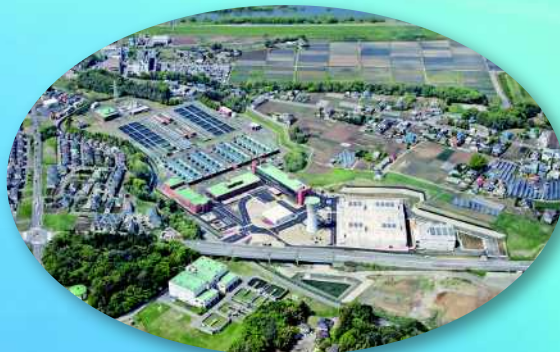
高度浄水処理（北千葉広域水道企業団）
