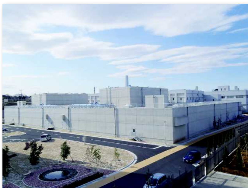
北千葉広域水道企業団 生物活性炭処理施設
