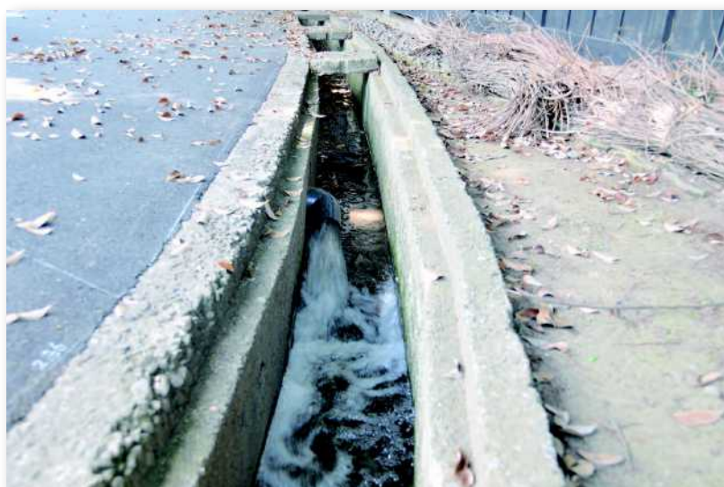
ドレン作業のようす
