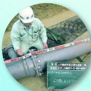
耐震管による配水管の整備
