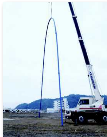
ポリエチレンパイプの吊上げ試験 (出典：配水用ポリエチレンパイプシステム協会)
