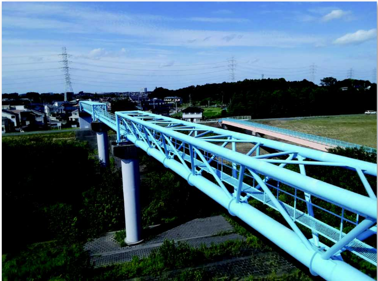
北千葉送水管(利根運河水管橋)
