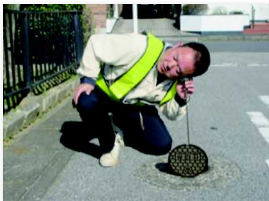
聴音による漏水調査のようす
