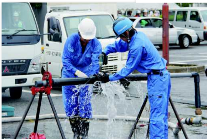
漏水復旧訓練のようす
