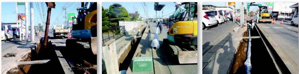
老朽管布設替のようす
