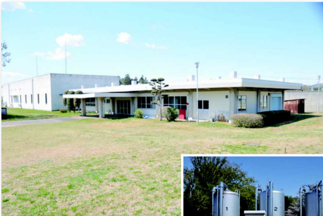
東金野井浄水場 管理棟
