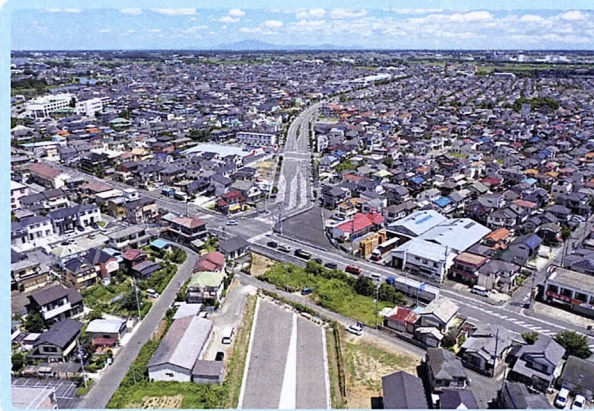
松伏町松伏地内 (主要地方道葛飾吉川松伏線交差部付近)
