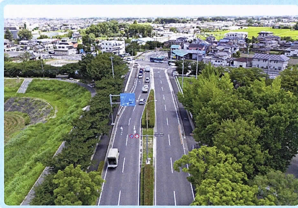
越谷市大吉地内 (主要地方道越谷野田線交差部付近)
