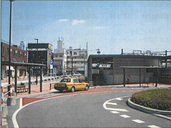
※平成 30 年 3 月 愛宕駅東口仮駅舎の供用開始
