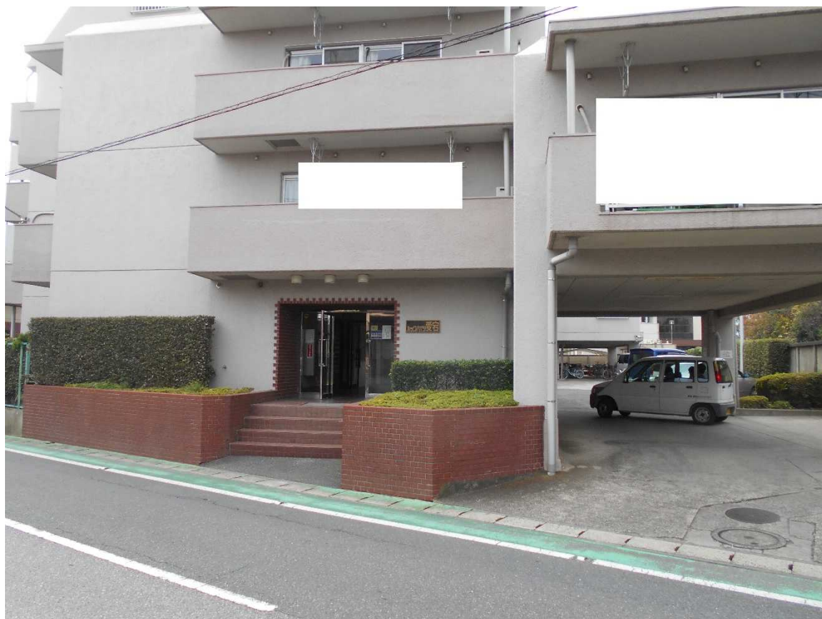
写真 2 : 共同玄関付近 東から撮影
