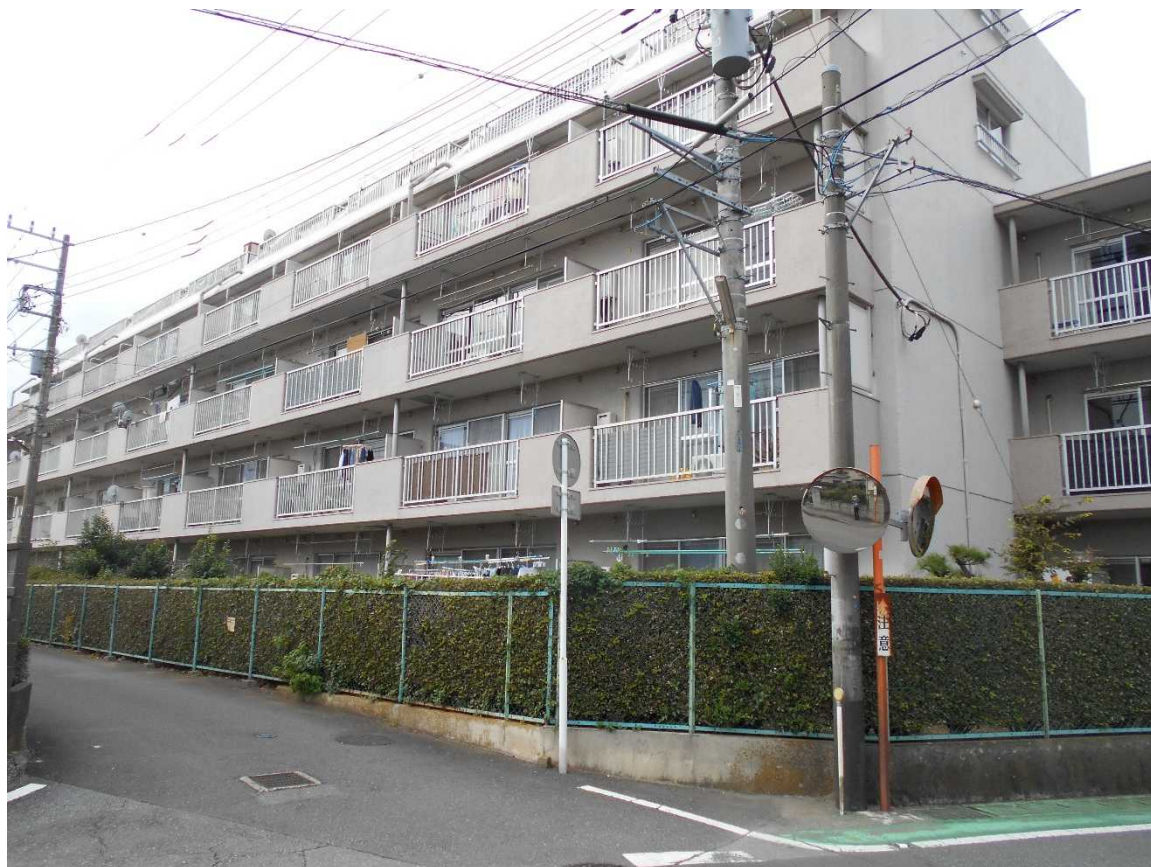
写真1：マンション外観 東から撮影
