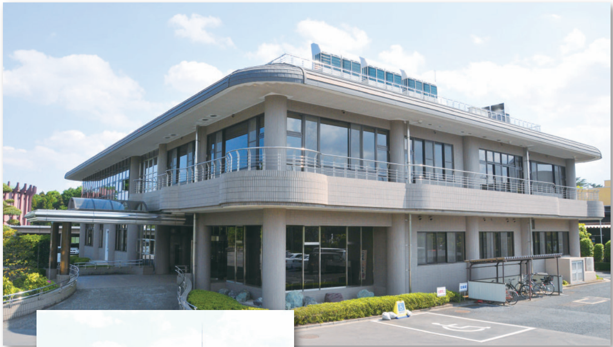
中根配水場 管理棟
