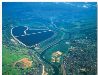
渡良瀬貯水池
