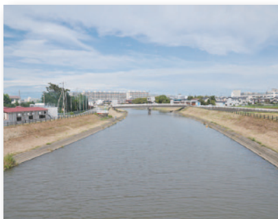
北千葉導水路
