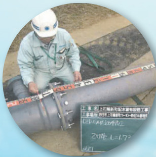
耐震管による配水管の整備
