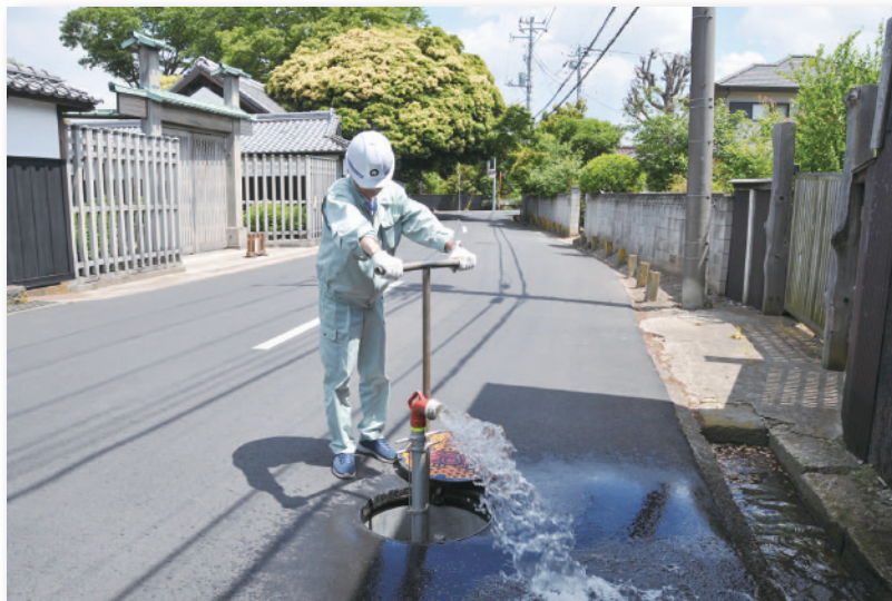
洗管作業のようす
