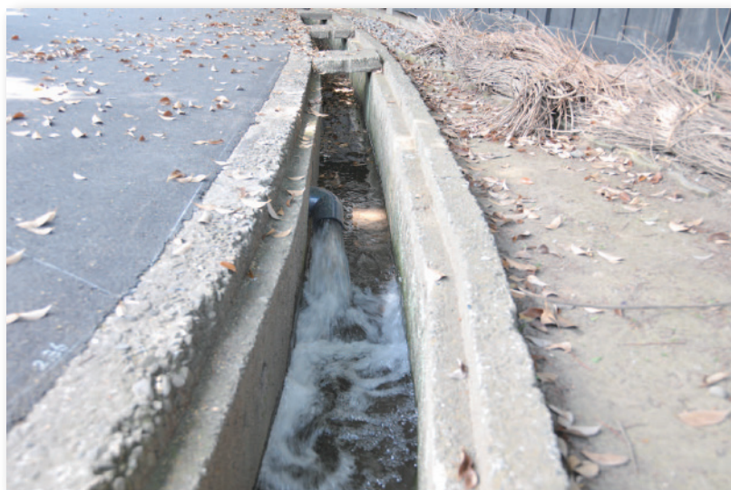
ドレン作業のようす
