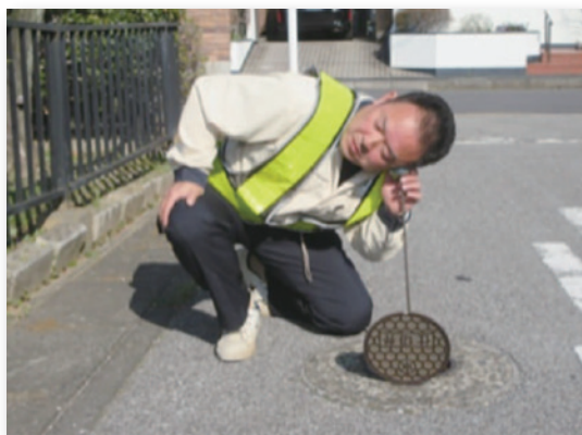
聴音による漏水調査のようす
