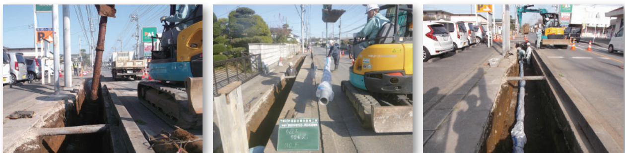
老朽管布設替のようす
