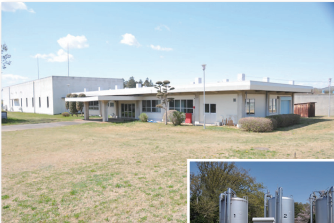
東金野井浄水場 管理棟
