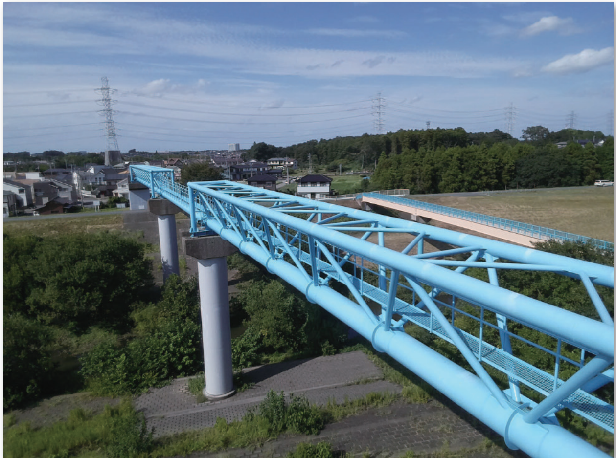
北千葉送水管(利根運河水管橋)
