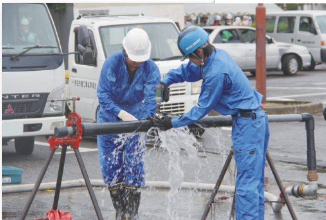
漏水復旧訓練のようす
