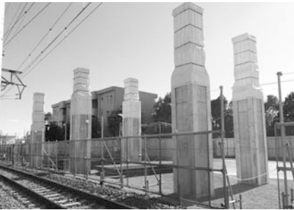
現在施工中の連続立体交差事業(野田市駅周辺)
