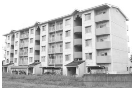
市営鶴奉団地2号棟
