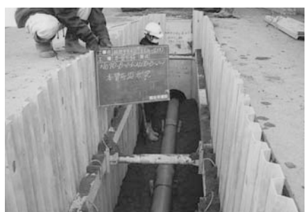
下水道管渠布設工事(柳沢地先)
