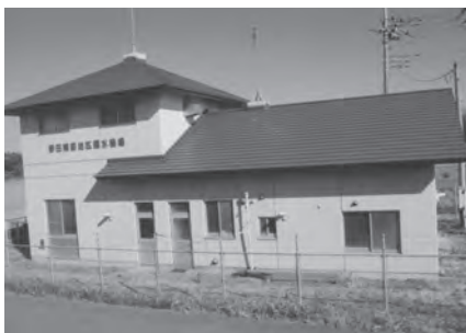
野田南部地区揚水機場（今上地先）
