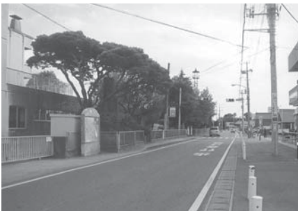
拡幅される木間ヶ瀬小学校前の県道
