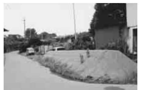
盛り土による築堤
