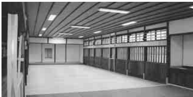
改修後の春風館道場
