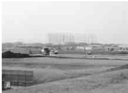
河川防災ステーション整備現場
