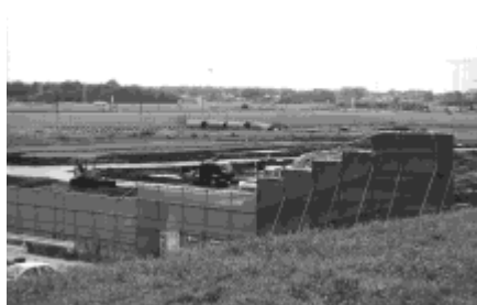
防災ステーション整備現場
