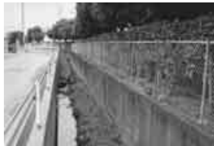
小森印刷脇水路
