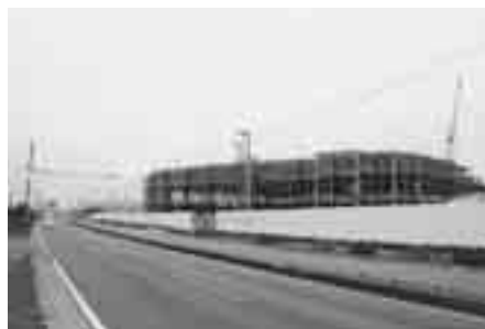
建設中の大規模物流センター
