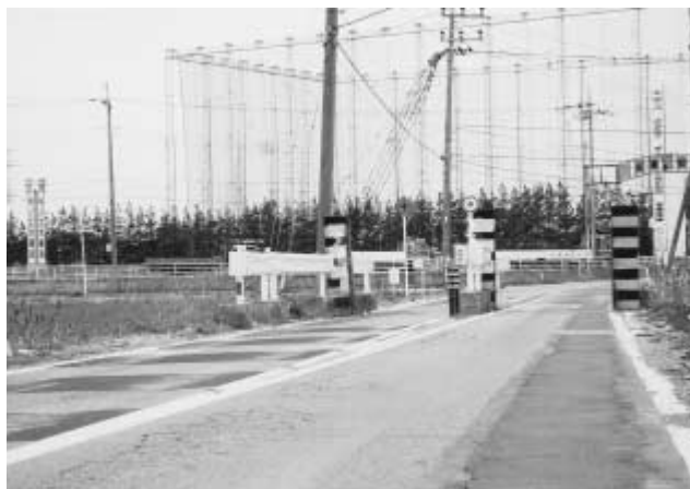
車幅規制のためのコンクリート柱(目吹地先の農免道路)
