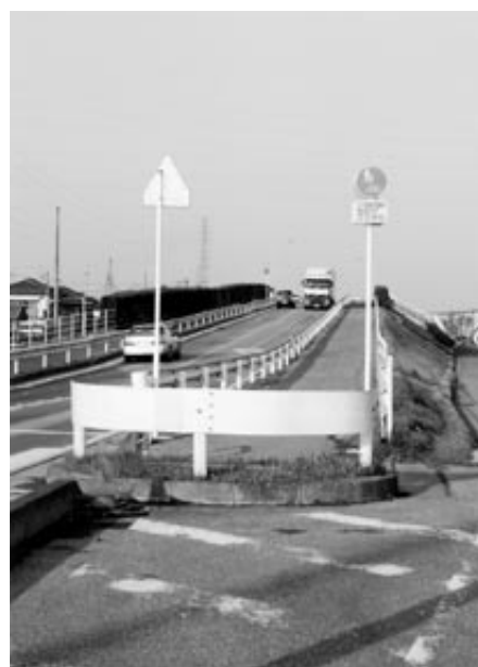
平成やよい通り（立体交差付近）
