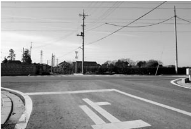
市道 2180 号線、県道我孫子関宿線交差点付近
