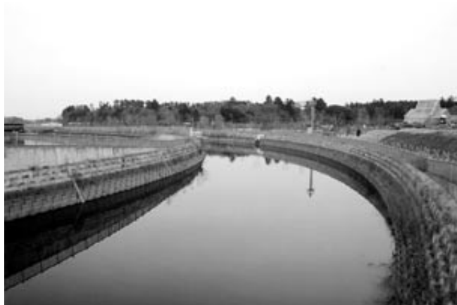
座生川改修（座生土地区画整理地内）
