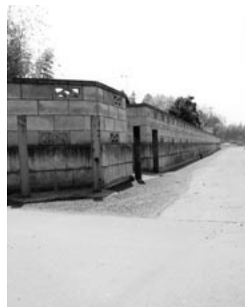
狭隘道路（セットバック箇所）
