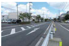
南部地区の工事予定箇所
