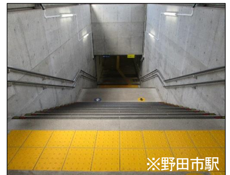
駅のエレベーター・エスカレーター未整備 (愛宕駅・野田市駅)
