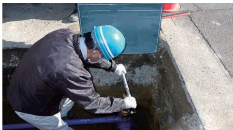
キッコーマン総合病院を専用水道管へ切り替える様子
