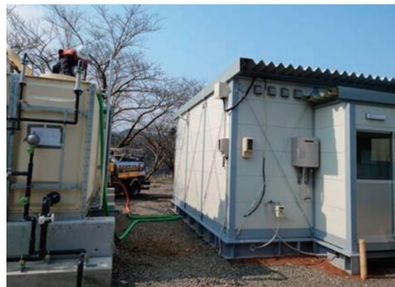
仮設住宅での生活を支える水を貯水槽へ
