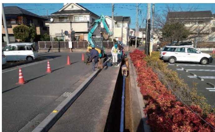
樹脂性の柔軟で地震に強い水道管を使用
