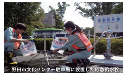
野田市文化センター駐車場に設置した応急給水栓
