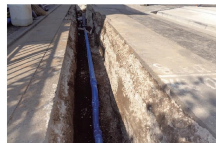
口径の小さい管は耐震性のあるポリエチレン管へ入替
