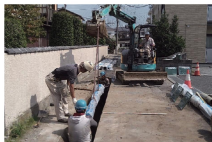
口径の大きい管は地震に強い铸铁管を使用
