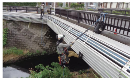
ロープで安全を確保しながら作業員が水道管を直接点検
