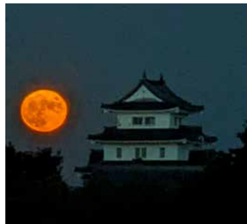
関宿水閘門付近から撮影
