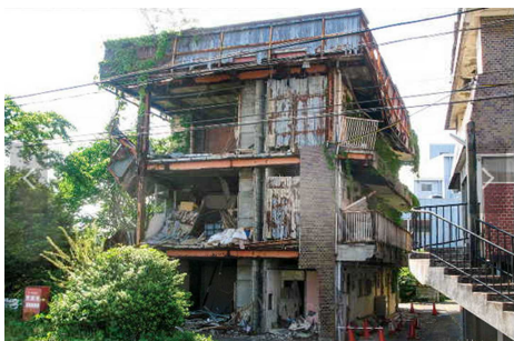
建物が損傷し廃墟化した事例
