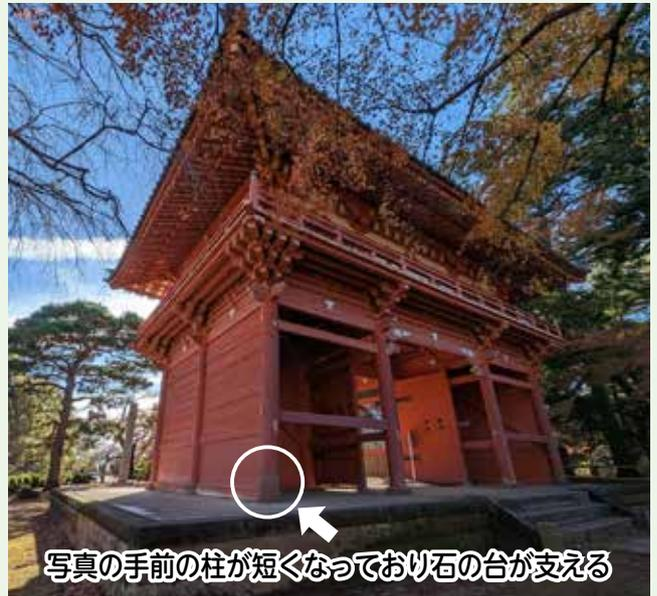
写真の手前の柱が短くなっており石の台が支える
