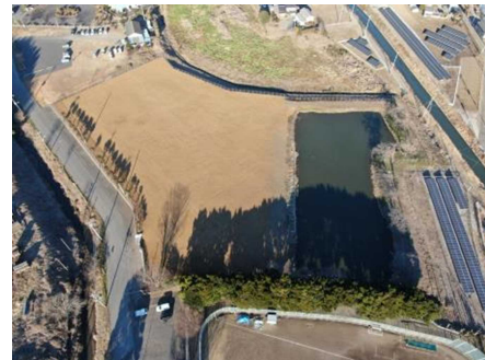
旧関宿クリーンセンター跡地
