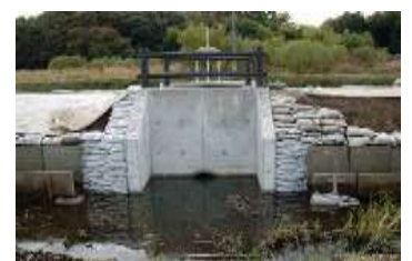
※江川排水路 樋管の写真
