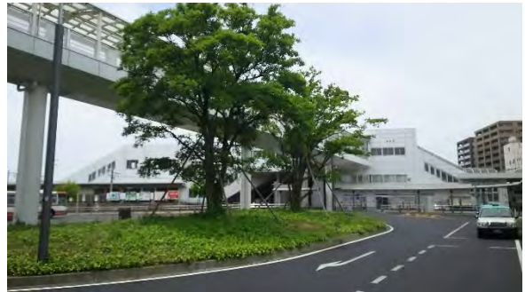
（写真）事務局撮影 図 駅とビルをつなぐ連絡通路
