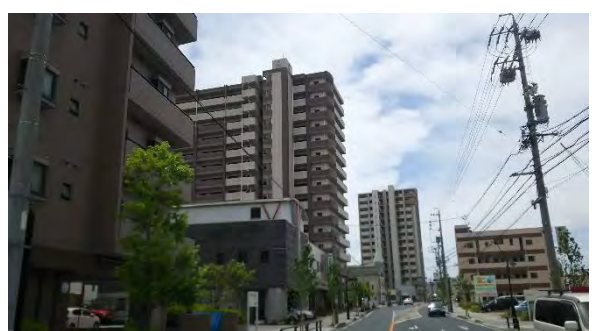
（写真）事務局撮影 図 駅周辺の高層マンション
