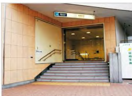
歩道より高く、防水扉を設置した出入口
