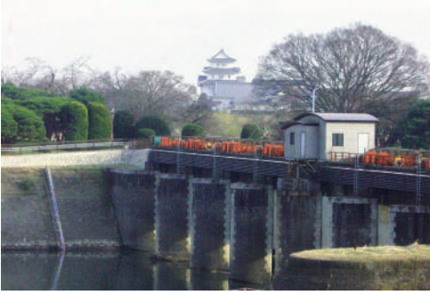
①現在も“現役”で活躍中の水閘門
