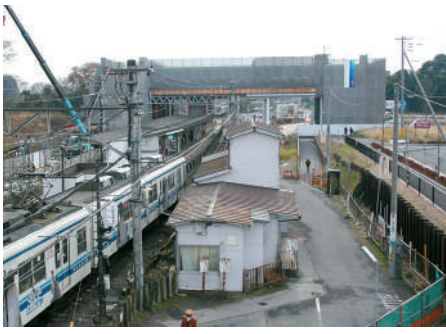
工事が進む七光台駅東西連絡自由通路
