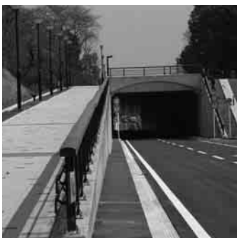
公園の景観に配慮して一部を地下構造に
