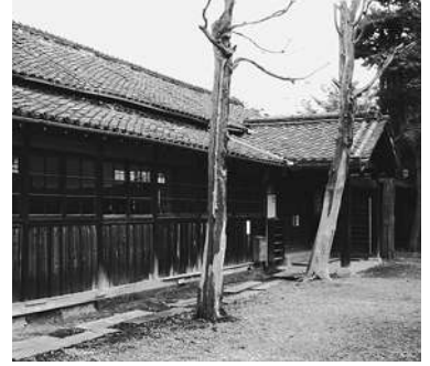
耐震設計などを行い「武道の殿堂」として整備へ
