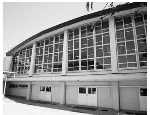
中央小体育館は改修と同時に耐震補強も
