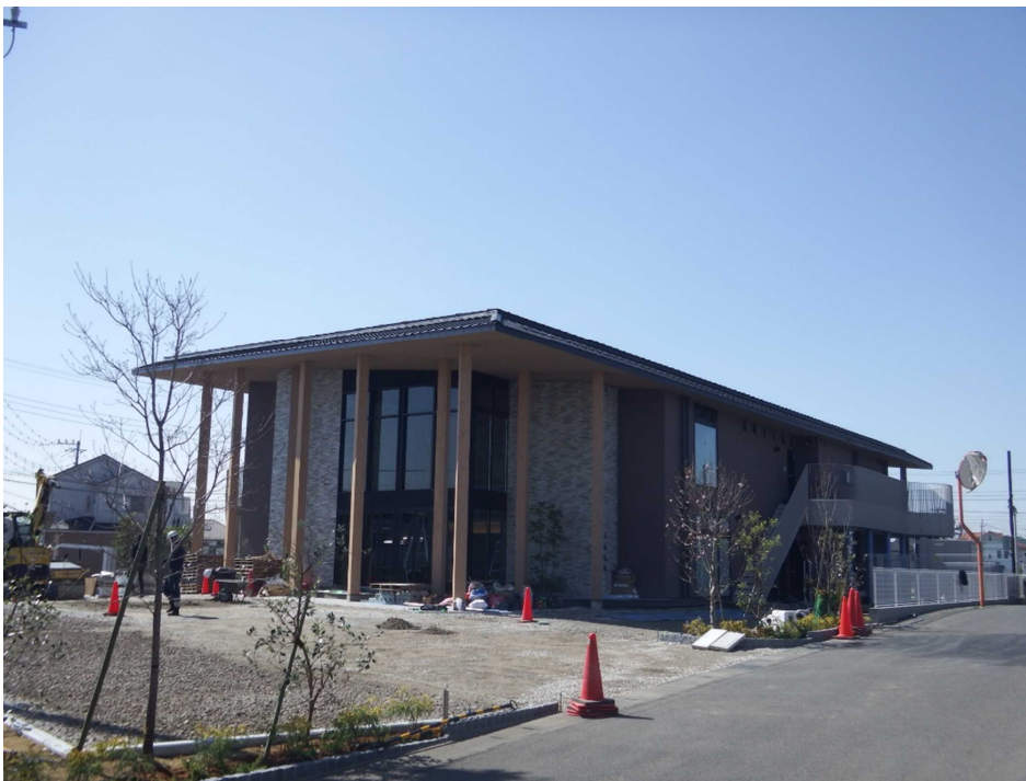
2階まで吹抜で解放感があるエントランス（外構工事中）
