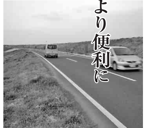
道路拡幅の要望に応じて整備
