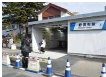
仮駅舎の改札は旧駅舎の南側へ移動
