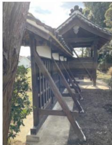
2-4 竣工脇塀右背面
