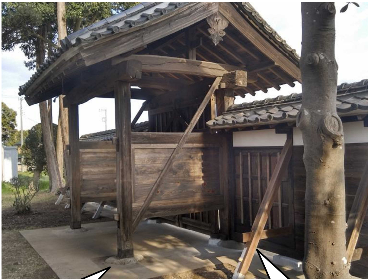
礎石据え直し
