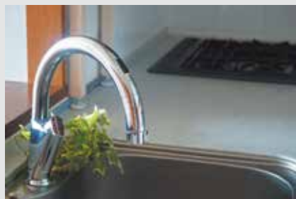
蛇口の水漏れ
