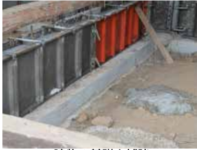
建物の基礎を補強
