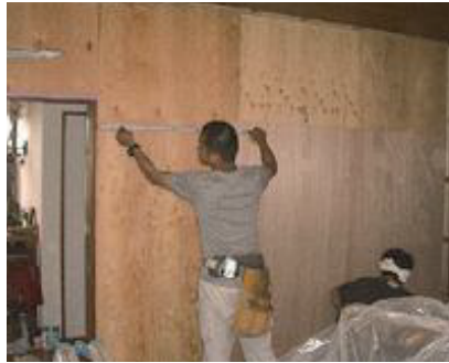
強い壁を入れて補強
