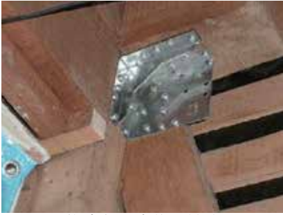
複合部を金物で補強
